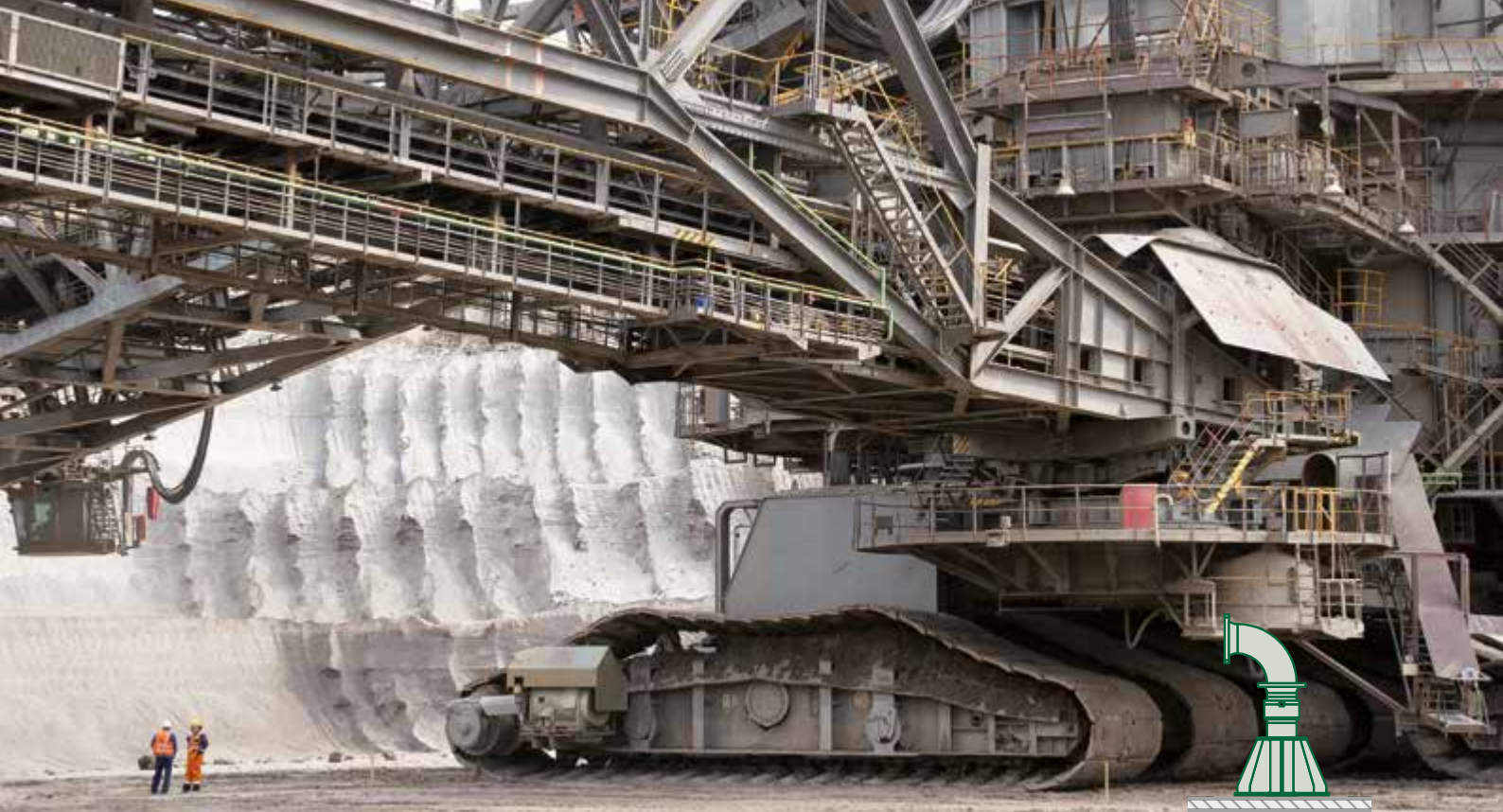
Einsatz der ZSM zum Grundwassermanagement im Braunkohlebergbau
