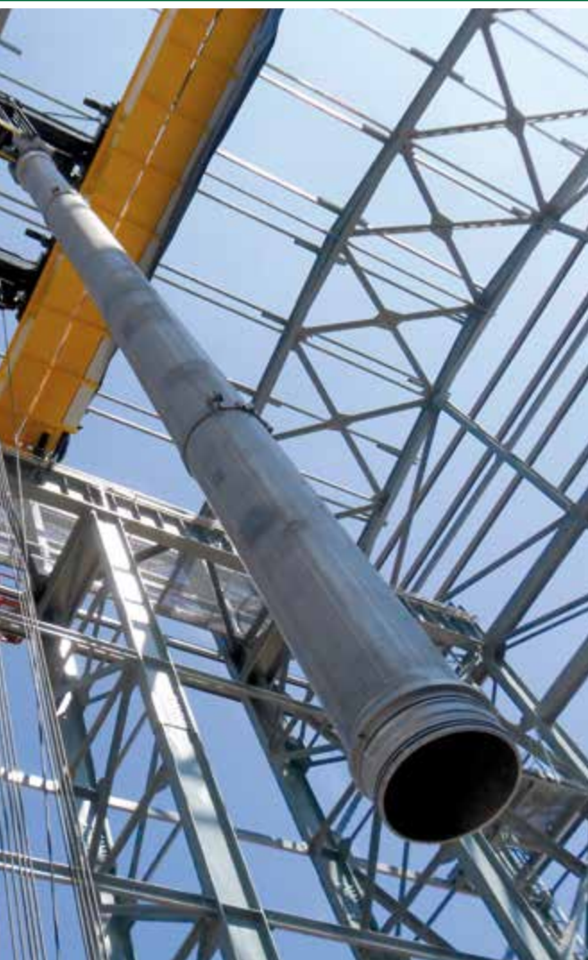
Einsatz einer Edelstahlleitung zur Entwässerung stark kontaminiertem Grubenwasser, Johannesburg, Südafrika
