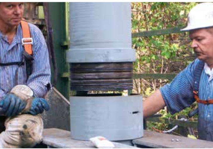
Einbau einer ZSM-Leitung
